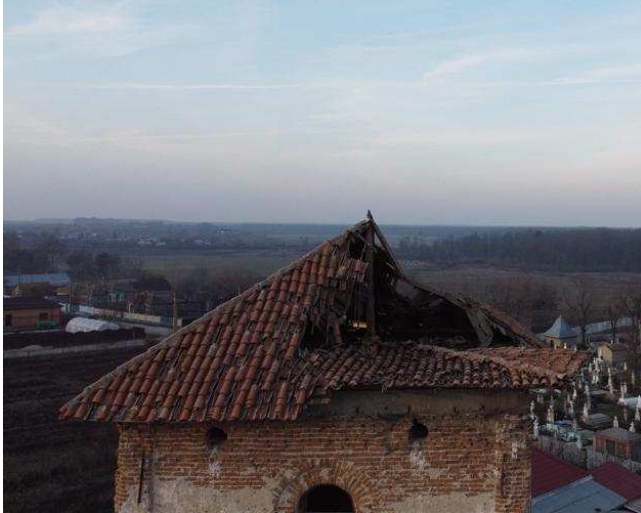
Fotografie cu șarpanta turnului, realizată din dronă - Octombrie 2020
